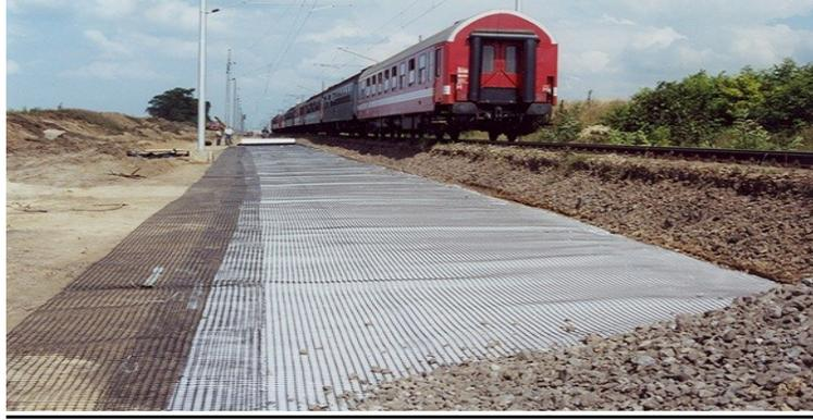
يستخدم في خطوط السكة الحديد في تقوية التربة ومقاومتها للإنهيار، ومنع اختلاط التربة الداخلية بطبقة الحجر الصخري.
